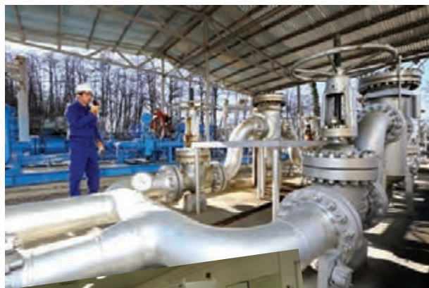
منطقه شمال - ایستگاه فشارشکن لاجیم
