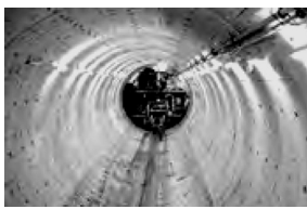
پوشش داخلی تونل به وسیله قطعات بتن
