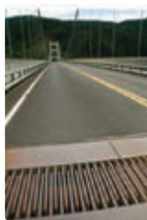
(ب) نمونه‌ای از بست‌های انبساطی
