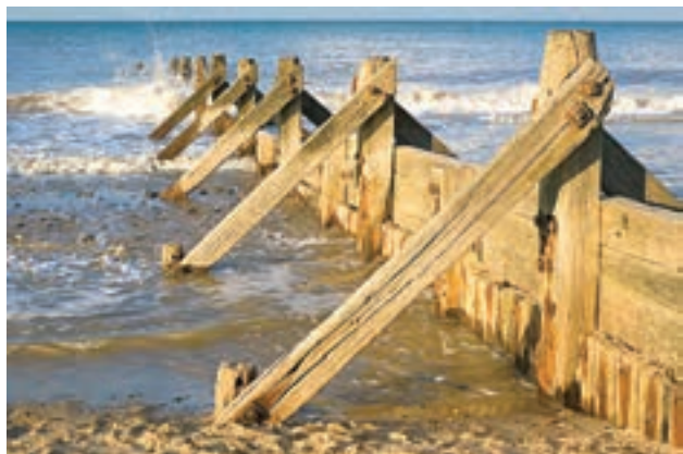
نصب حفاظ عمودی
