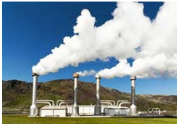
شکل ۱۴-۶: نیروگاه زمین گرمایی مشکین شهر
