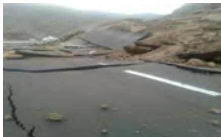
شکل ۹-۴: لغزش در ترانشه یک جاده
