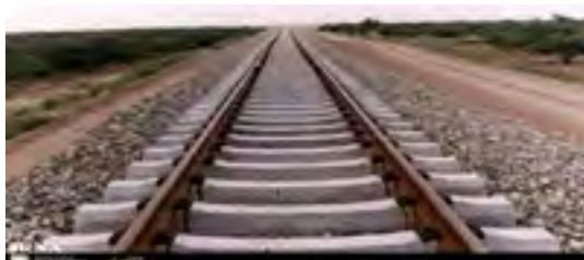
شکل ۱۱-۴: بالاست در زیرسازی جاده ریلی
