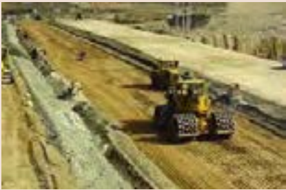
مراحل ساخت سد خاکی
