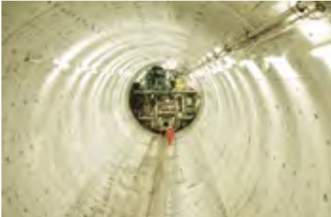
شکل ۶-۴: پوشش داخلی تونل به وسیله قطعات بتن
