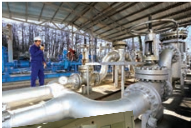
منطقه شمال، ایستگاه فشار شکن لاجیم
