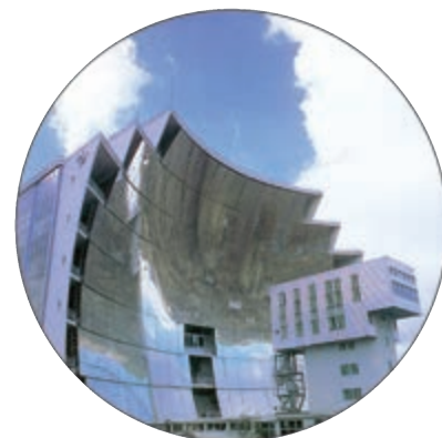
شکل ۱-۱۶- نمایی از نوعی کوره خورشیدی که در آن از آینه‌های مقعر بزرگ استفاده شده است.
