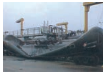
شکل ۲۲-۶- سرد شدنِ هوای درون مخزن باعث کاهش فشار این هوا و در نتیجه مجاله شدن مخزن شده است.
