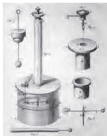
شکل ۱-۲ ترازوی پیچشی کولن. در دو سر یک میله سبک افقی یک کره کوچک و یک قرص قرار دارد. یک کره مشابه از حفره‌ای به داخل برده می‌شود. نیروی مؤثر بین بارها از اندازه‌گیری زاویه چرخش ترازوی پیچشی تارسیدن به تعادل به دست می‌آید. (تصویر از کتاب مرجع سال ۱۳۸۵م.)
