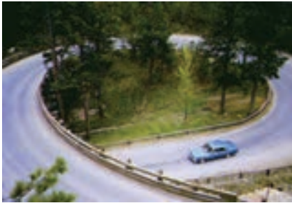
شکل ۲-۱۳-پ - تصویری از حرکت اتومبیل در شیب عرضی جاده
