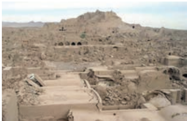
ب- ارگ بم بعد از وقوع زلزله
