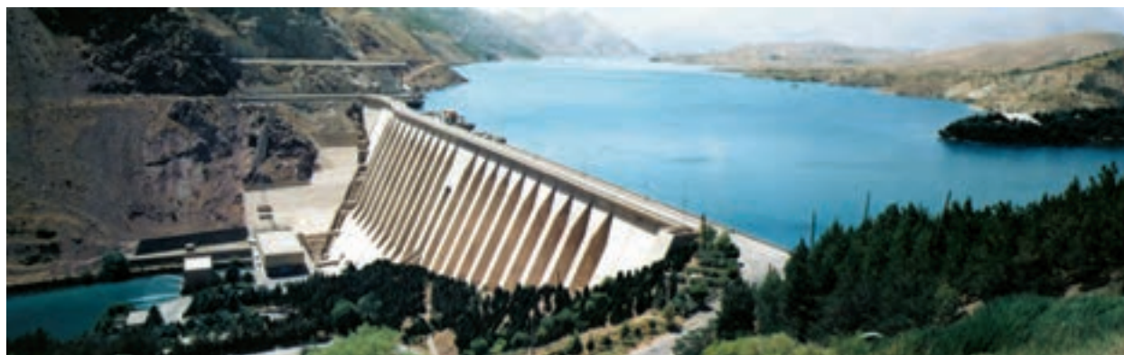
شکل ۲۶-۶- احداث سد روشی برای کاهش خطر خشک‌سالی
