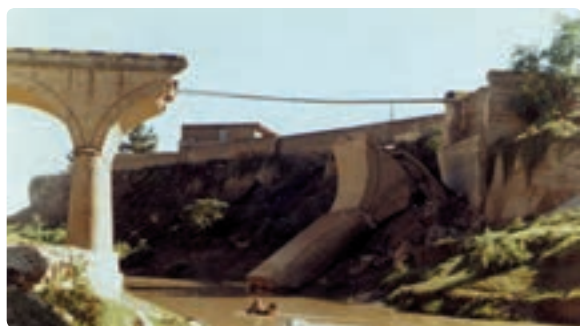
شکل ۱۵-۶- تخریب یک پل ارتباطی بر اثر سیل
