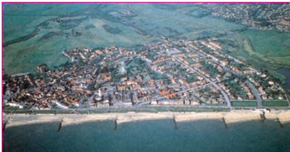
شکل ۷- احداث حفاظ در سواحل ماسه‌ای
