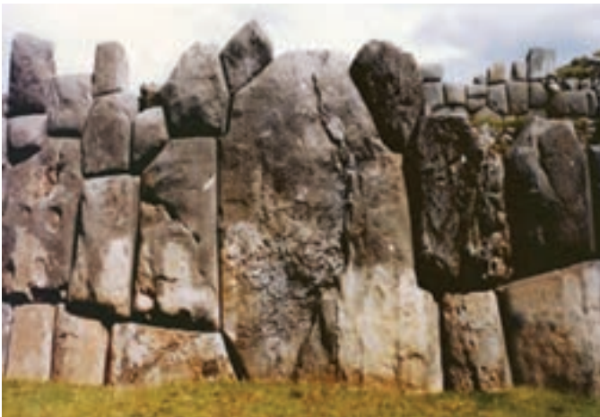
شکل ۴-۶- نمایی از درزه که با ایجاد شکستگی در سنگ آشکار شده است
