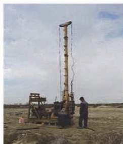
حفاری گمانه اکتشافی توسط دستگاه حفاری مغزه‌گیری توسط گمانه‌های اکتشافی
