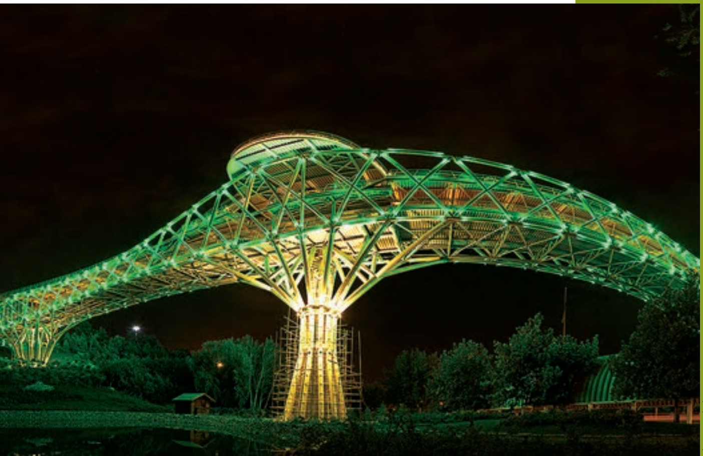
پل طبیعت - تهران
