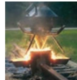
از واکنش ترمیت برای جوش‌دادن خطوط راه‌آهن استفاده می‌شود.
